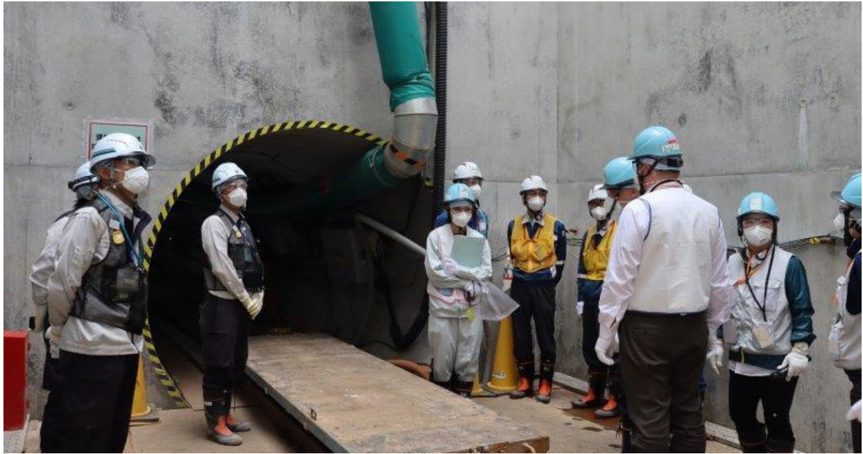
그림 3.9. 방전 터널 시공 검사
